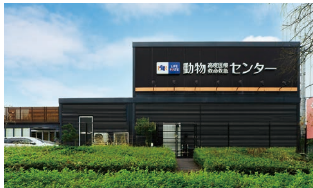
ライフメイト動物高度医療センター八王子(東京都八王子市)
